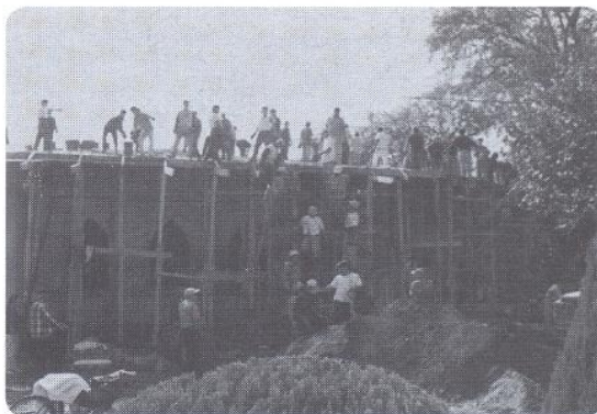
Construcción de la capilla, finales de los 90's
