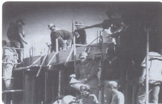
Construcción de laboratorios de ciencias biomédicas, Década de los 90's
