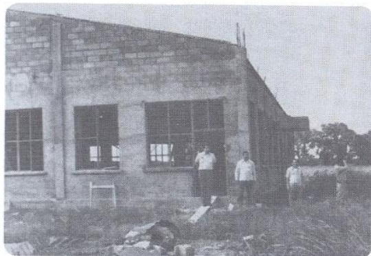
Edificio del comedor en obra negra, 1975
