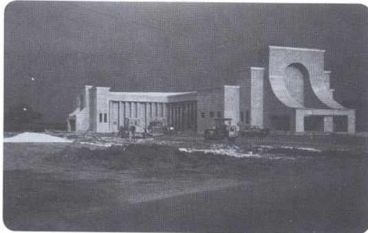
Maquinarias haciendo el estacionamiento
