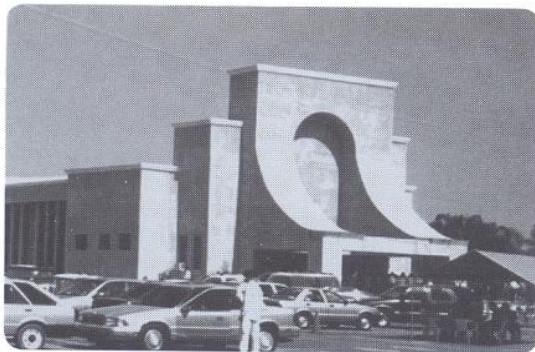
Inauguración del estacionamiento
