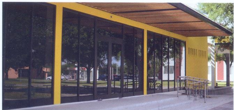
Remodelación de la fachada del Comedor
